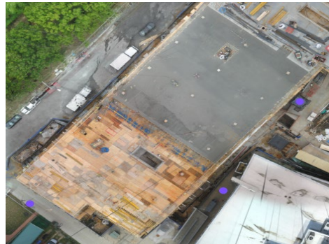
Placa de concreto fundida
